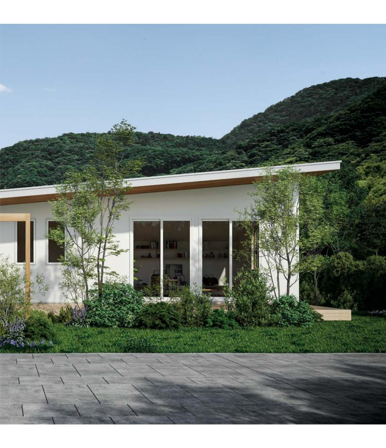
南向きの1階リビングと2階居室に大開口の窓を設けて、冬の日差しをたっぷり採り込み、 夏の日差しは深い軒でカット。外観のアクセントとして、玄関上にスクエア窓を配置。
